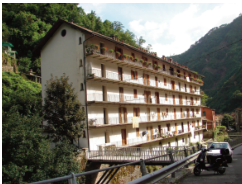
Figura 7: foto scattata il giorno 11 dicembre 2009: vista del Palazzo Operaio da Via Commercio (Foto Guidarelli)
